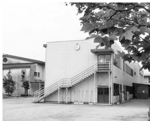
西野小35人学級設置に伴い職員室等に予定されるプレハブ棟
